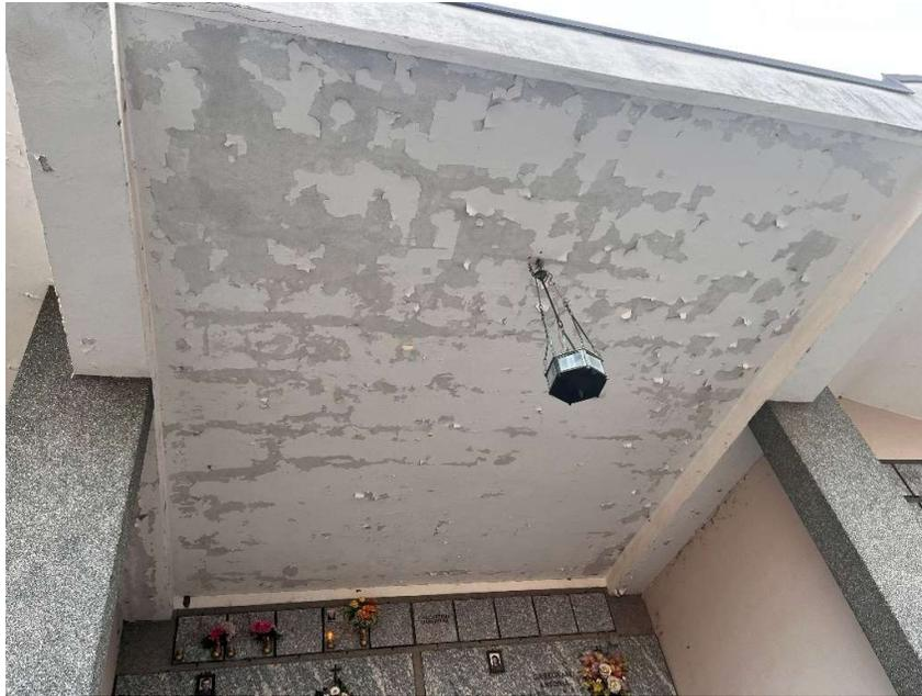
*Vista del deterioramento degli intonaci dei plafoni del blocco loculi nord*
